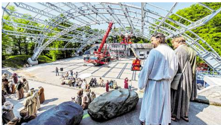
170 Tonnen schwer ist die Stahlkonstruktion für die Überdachung.
